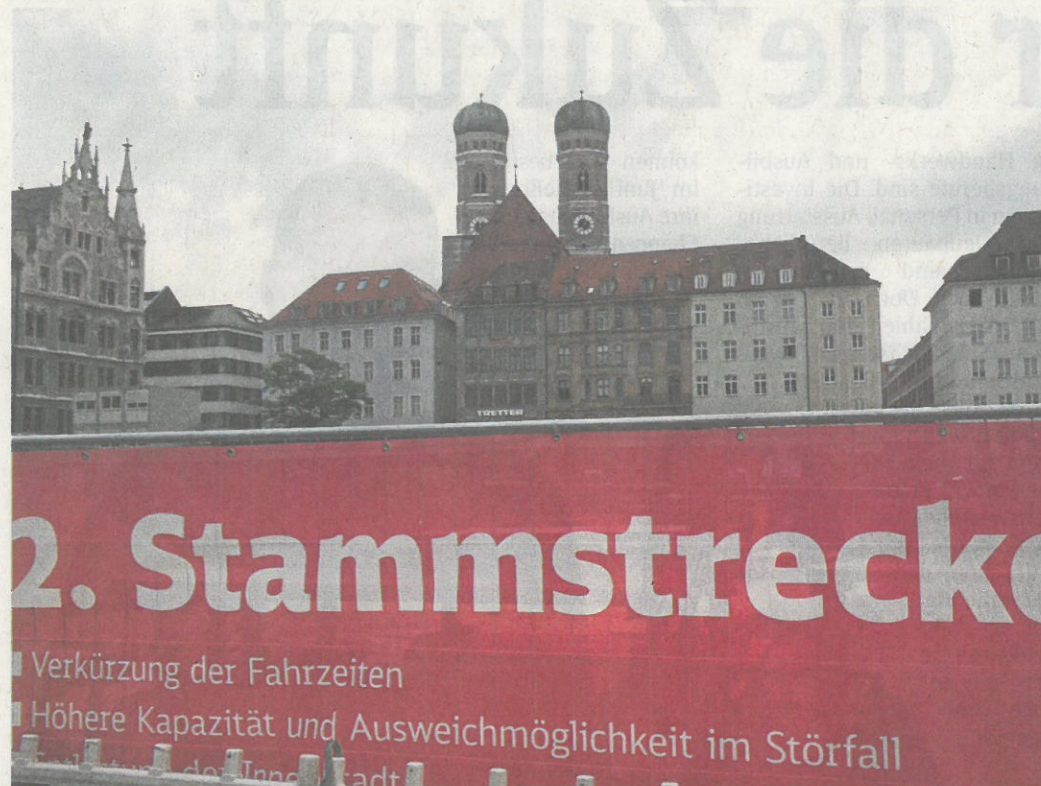
Der rote Sichtschutz der Stammstrecken-Baustelle am Marienhof.
