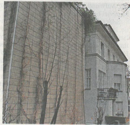
Ein Anbau (links), der das Ensemble sprengt: die Gaertner-Klinik an der Possartstraße.
