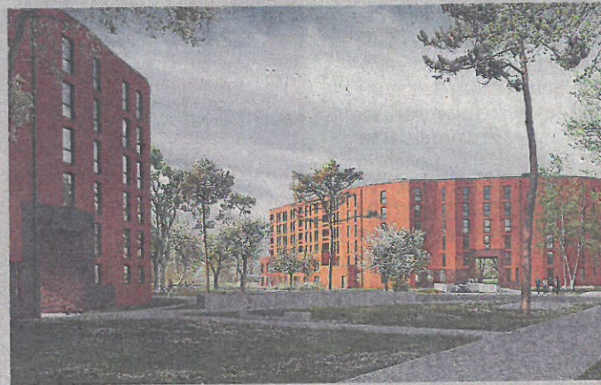
Diese Bauten in Klincker-Optik sollen acht statt sechs Stockwerke bekommen. Dagegen klagen Anwohner.
