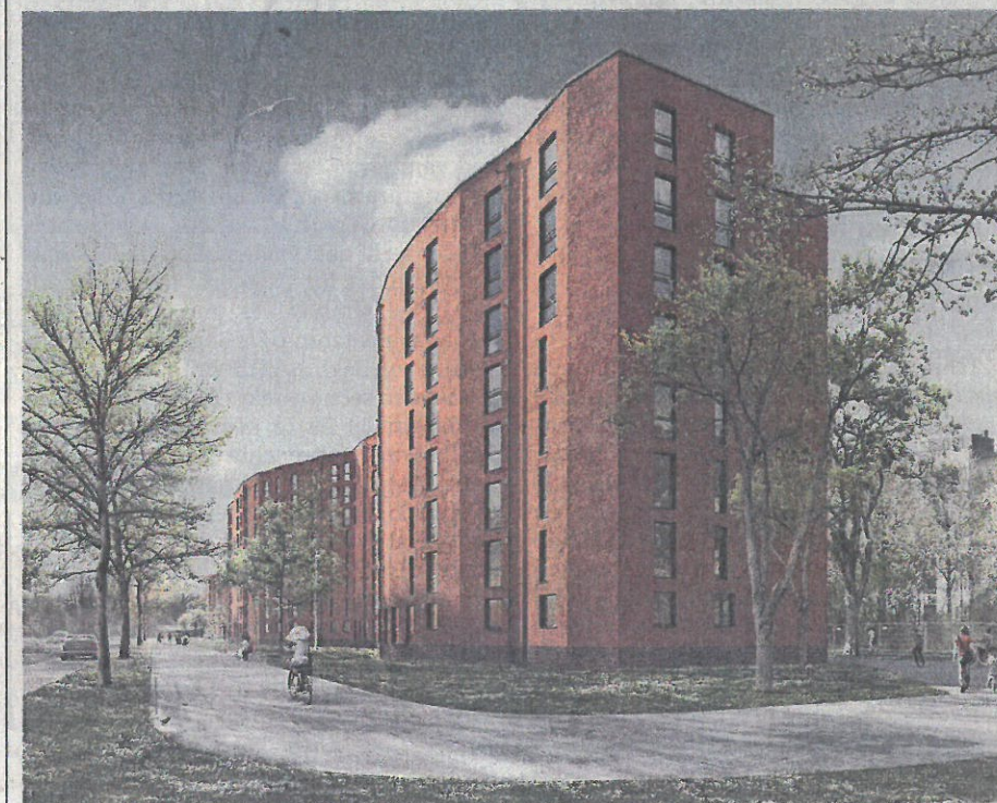
Steine des Anstoßes: Nachbarn klagen gegen die nachträgliche Genehmigung zweier Stockwerke bei dem Projekt an der Carl-Wery-Straße. SIMULATION: MAIER NEUBERGER ARCHITEKTEN
