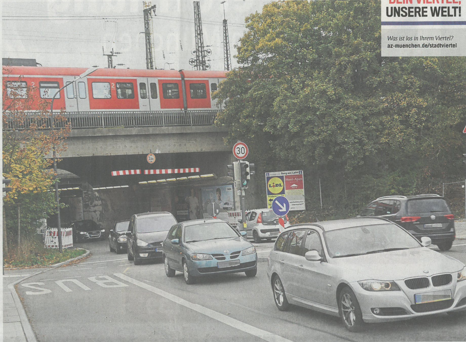
Kommt die SEM wie geplant, dürfte es hier noch enger werden: die Unterführung an der Hultschiner Straße, oben der S-Bahn-Halt Berg am Laim.
