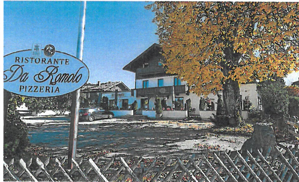
Der Abriss ist beschlossene Sache. Die Pizzeria in Schaftlach wird durch einen Neubau ersetzt. Mit dem ersten Spatenstich ist 2020 oder 2021 zu rechnen. Die alte Linde bleibt erhalten.
