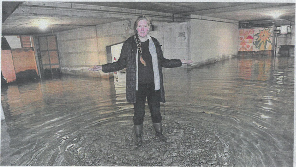
Wassermassen in der Tiefgarage: Franziska von Gagern (50) ist einer der Schwabinger Anwohner, bei denen die Keller überflutet sind.
