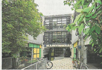
Ein Denkmal in Gefahr: Das Haus in der Genter Straße läuft andauernd mit Grundwasser voll Fotos: Oliver Bodmer
