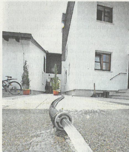
Die Keller müssen seit 2010 immer wieder ausgepumpt werden. FOTO: STEPHAN RUMPF
