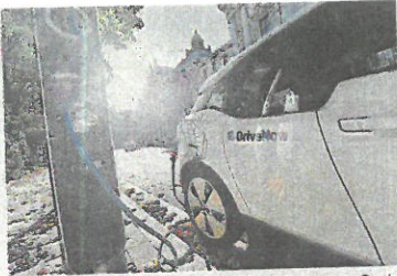
Eine Elektro-Tankstelle an der Eisenstraße in München Foto: Sigi Jantz
