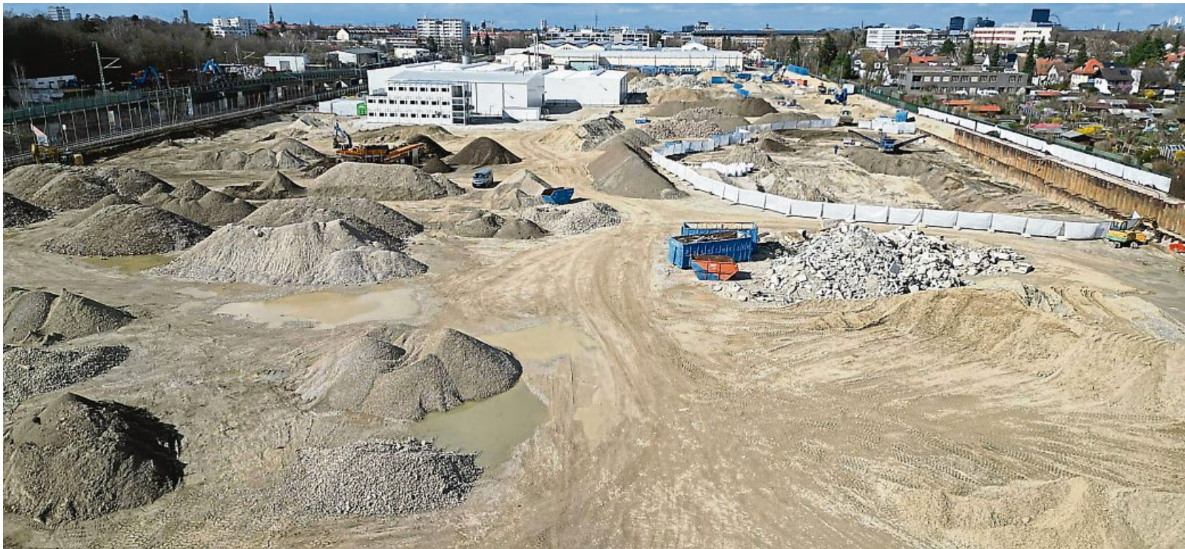
An der Ständlerstraße soll der neue Trambahnbetriebshof entstehen.
