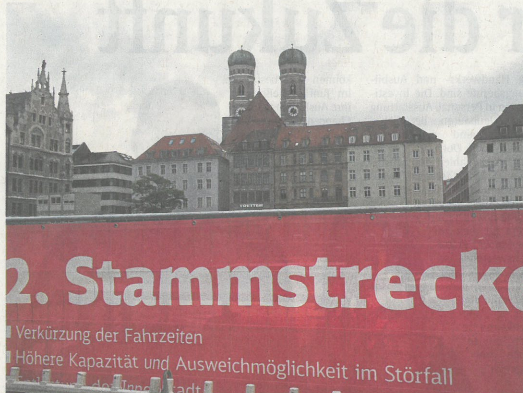
Der rote Sichtschutz der Stammstrecken-Baustelle am Marienhof.
